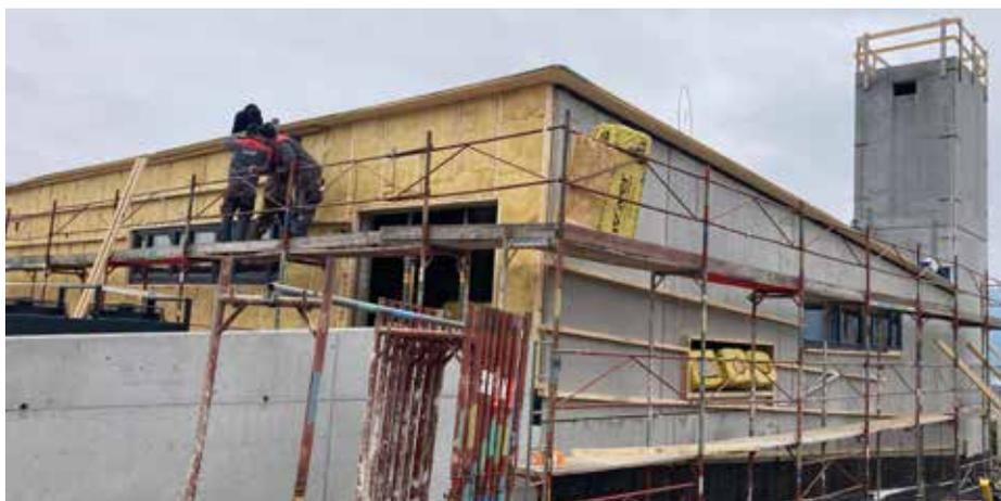
*Die Errichtung der Unterkonstruktion und Dämmung für die Schindelfassade.*
