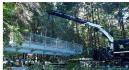
In Präzisionsarbeit wurde die neue Brücke in die bestehende Vorrichtung eingebracht.
